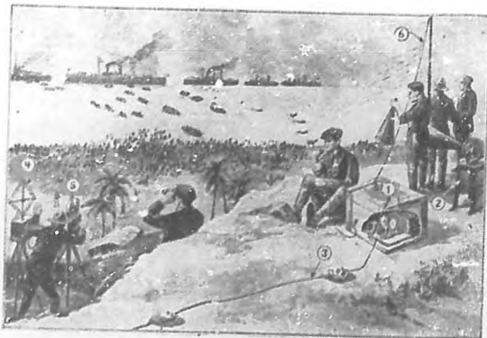
Usando un transmisor de ondas cortas, el director cinematográfico de una película de Cuba, que representa el desembarco de la caballería americana en playas, pudo gobernar los movimientos de los barcos de guerra, transportes, lanchas, etc., y pudo ordenar a los operadores cuándo comenzar y cuándo debían suspender. 1.—Transmisor; 2.—Sirena; 3.—Antena de compensación; 4.—Cámara cinematográfica; 5.—Receptor; 6.—Antena.
